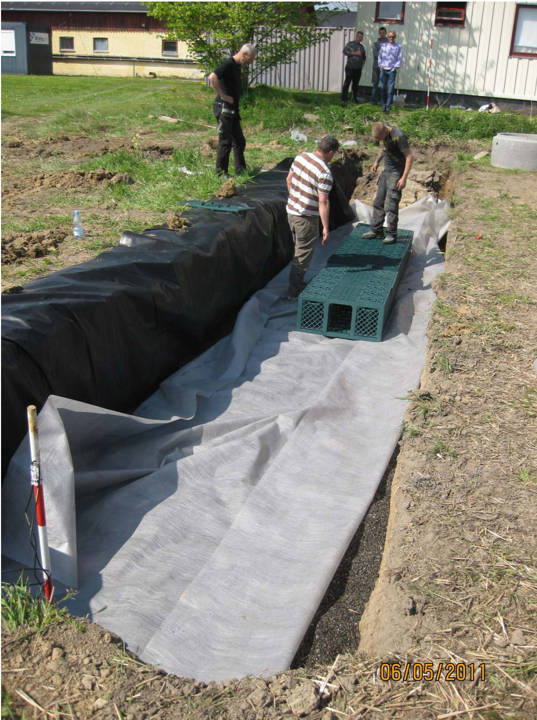
BILLEDE 5 UDLÆGNING AF PERMEABEL GEOTEXTIL I BUND AF FASKINE.
