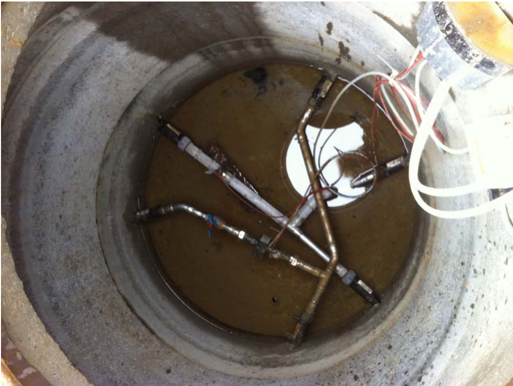
BILLEDE 13 DER HAR VÆRET OBSERVERET MINDRE FROST UDEN PÅ JORDVARMESLANGER I MÅLERBRØND FOR REFERENCEN (APRIL 2012).
