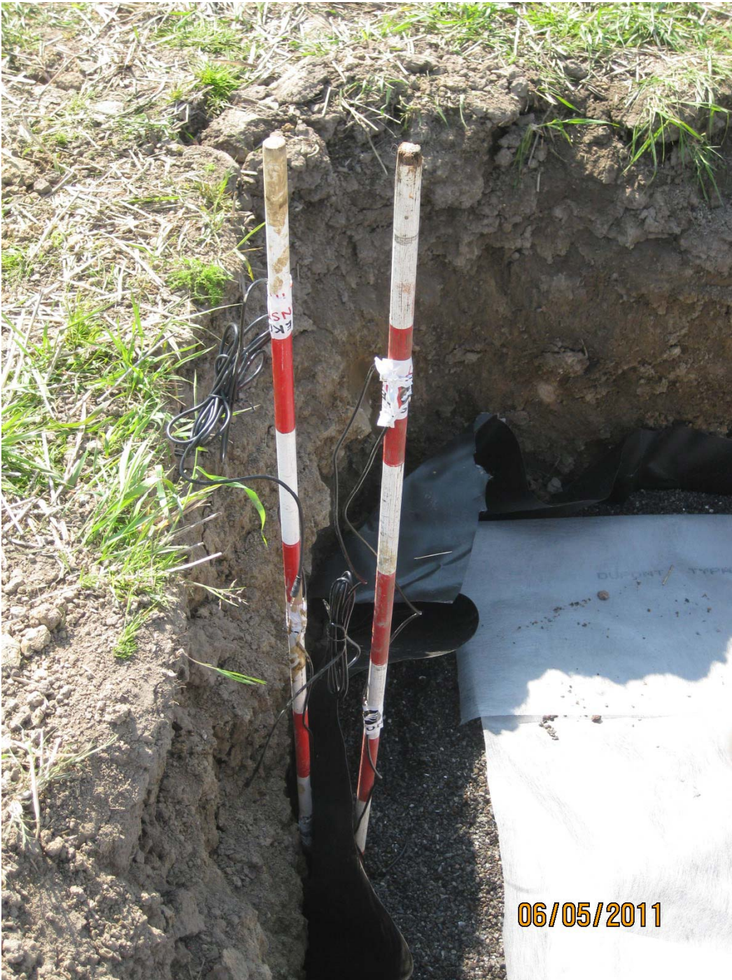
BILLEDE 8 MONTERING AF FUGTSENSORER I PROTOTYPE 2, HHV. INDENFOR OG UDENFOR MEMBRAN.
