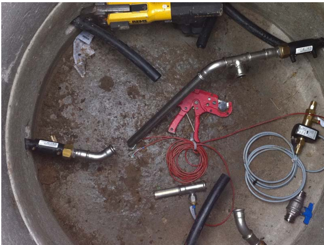
BILLEDE 4 MONTERING AF ENERGIMÅLER I MÅLERBRØNDE.
