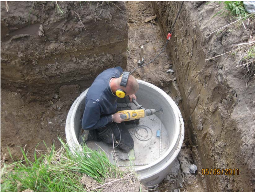
BILLEDE 4 PÅBORING AF HULLER I BRØND TIL JORDVARMESLANGER.
