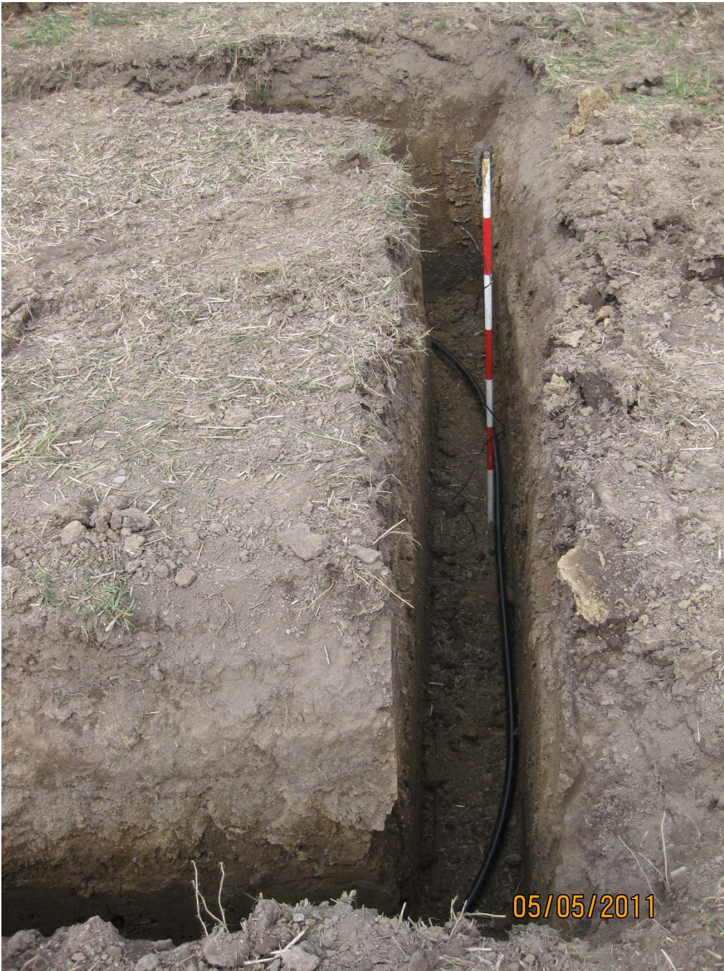
BILLEDE 7 MONTERING AF FUGTSENSOR I REFERENCEN SAMT I PROTOTYPE 1.
