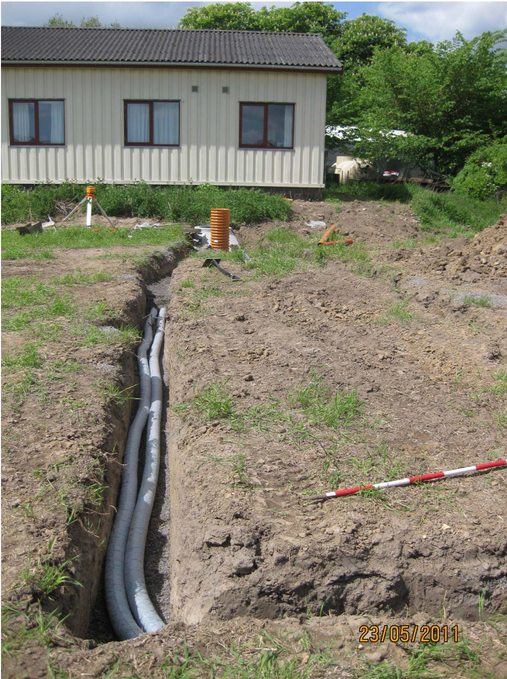
BILLEDE 8 FÆRDIGT TRACÉ MED DRÆN.
