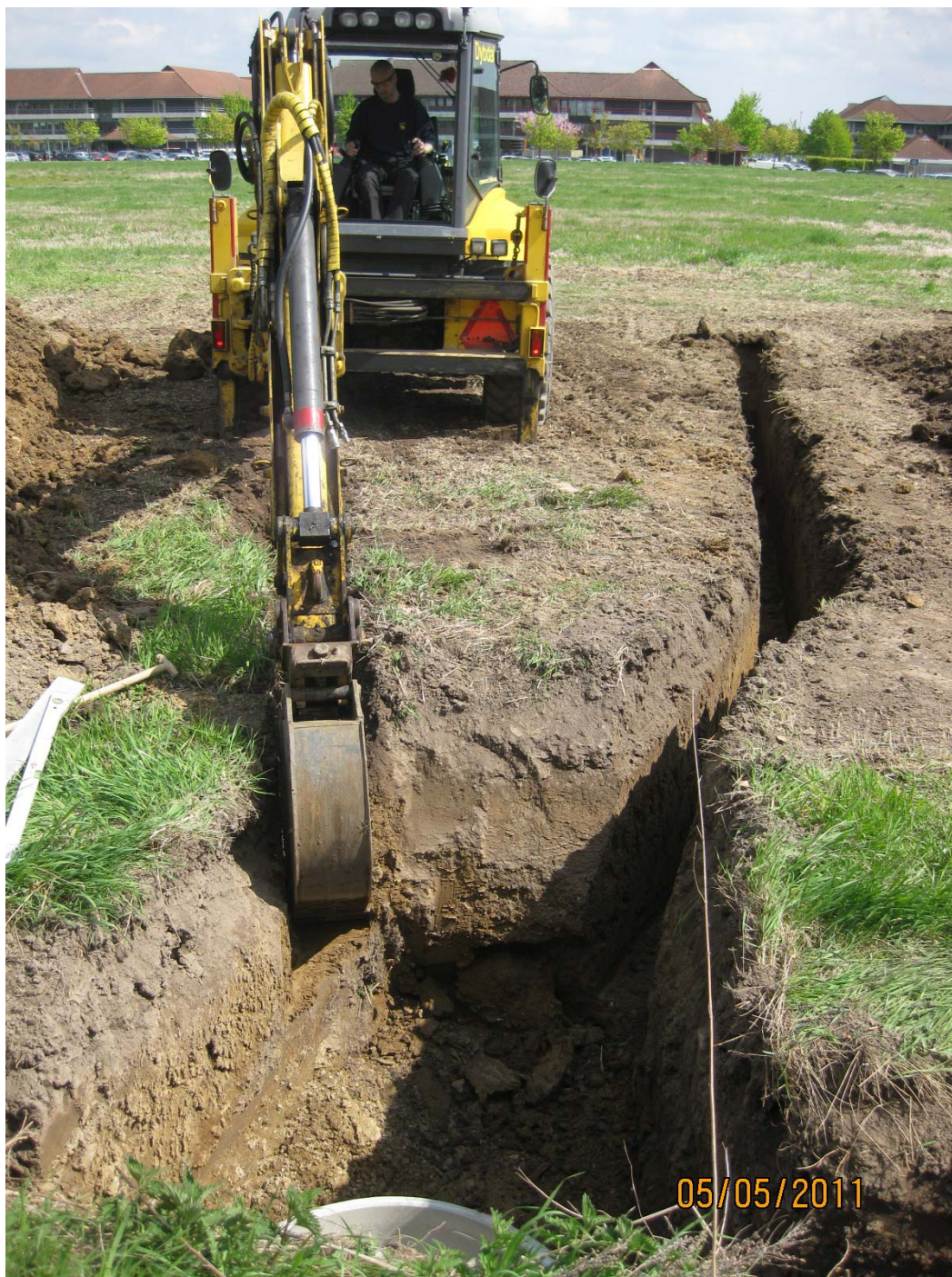
BILLEDE 1 UDGRAVNING AF TRACÉ.
