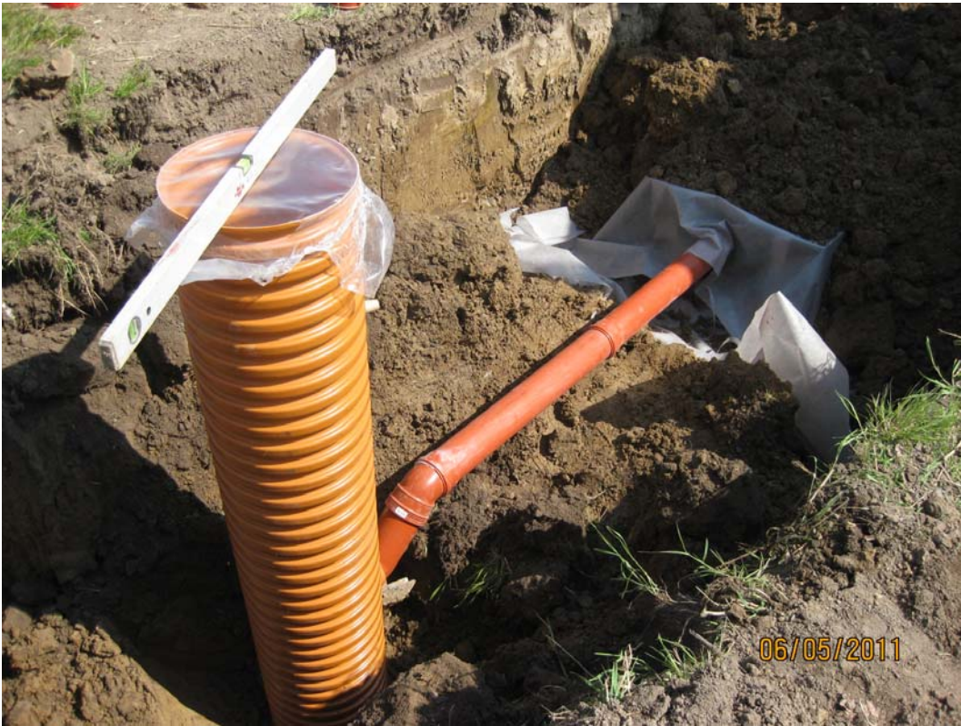
BILLEDE 8 ETABLERING AF SANGFANGSRØND FØR FASKINE.
