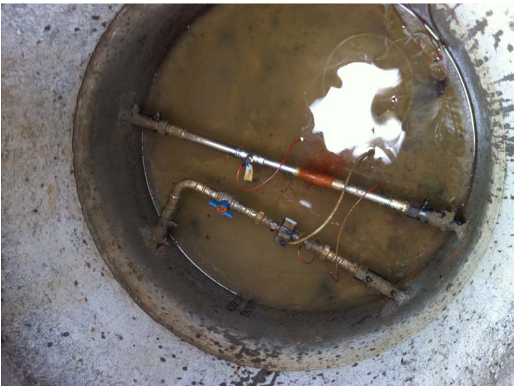
BILLEDE 12 DER HAR IKKE VÆRET OBSERVERET FROST UDEN PÅ JORDVARMESLANGER I MÅLERBRØND FOR PROTOTYPE 2 SPOLER (APRIL 2012).
