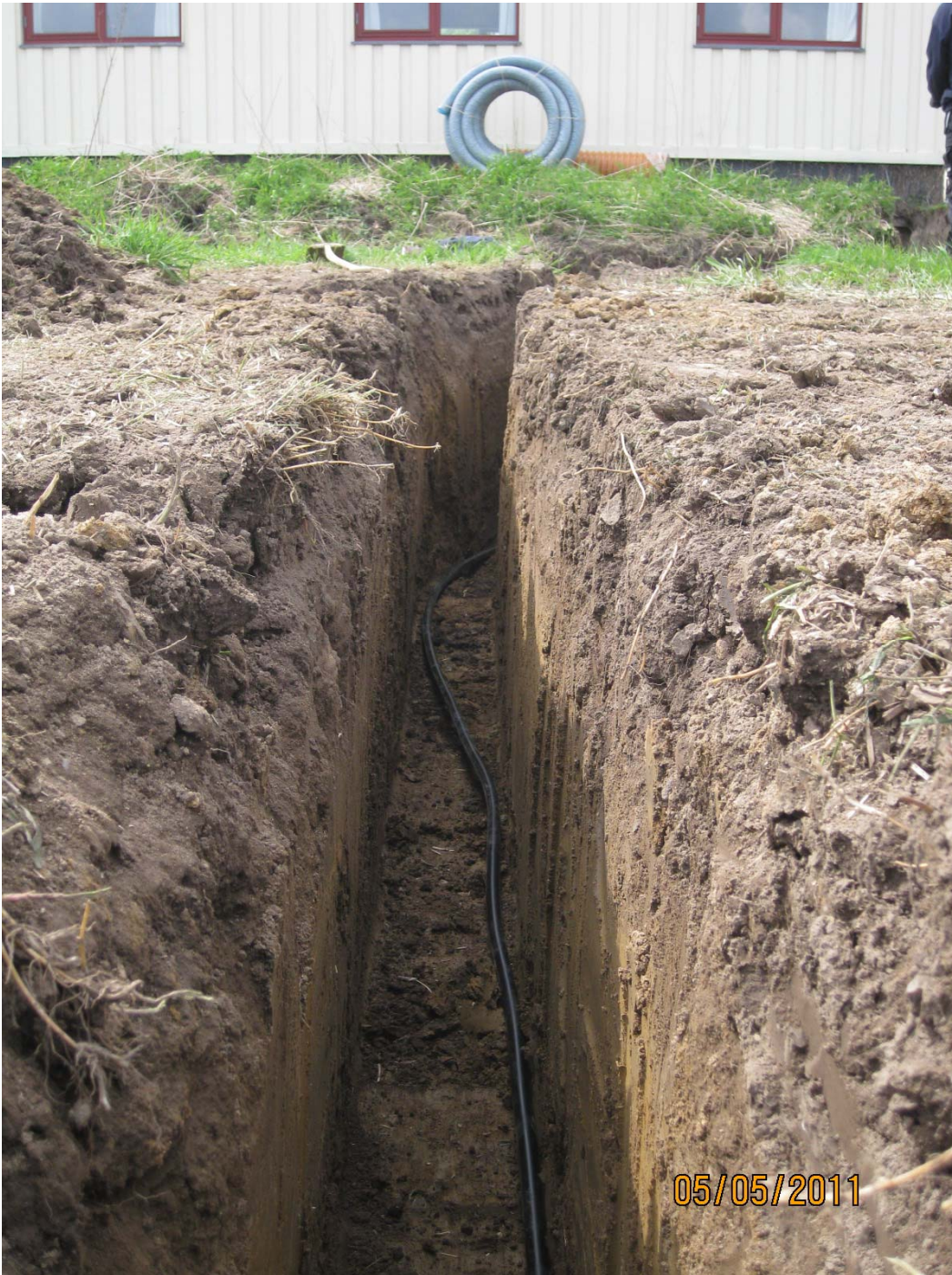
BILLEDE 5 UDLÆGNING AF JORDVARMESLANGE.
