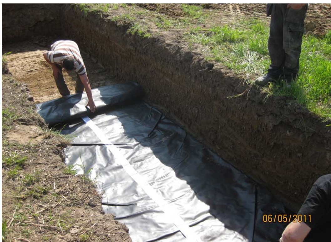
BILLEDE 1 UDLÆGNING AF IMPERMEABEL MEMBRAN.
