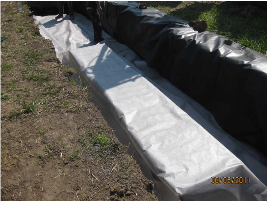
BILLEDE 6 UDLÆGNING AF PERMEABEL GEOTEXTIL I TOP OG SIDER AF FASKINE.
