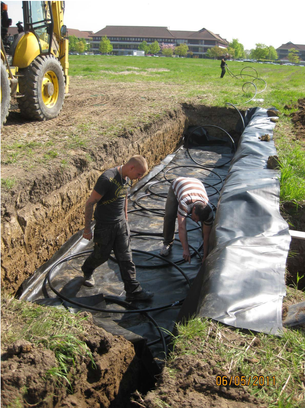
BILLEDE 2 UDLÆGNING AF JORDVARMESLANGER SOM SPOLER.
