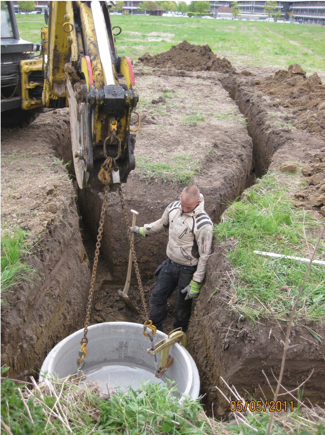
BILLEDE 3 SÆTNING AF BRØND TIL SAMLING AF OG MÅLEUDSTYR PÅ JORDVARMESLANGER.
