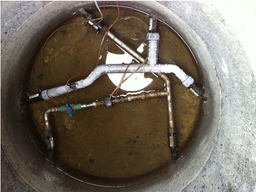
BILLEDE 11 DER ER OBSERVERET MEGET FROST UDEN PÅ JORDVARMESLANGER I MÅLERBRØND FOR PROTOTYPE 1 DRÆN (APRIL 2012).
