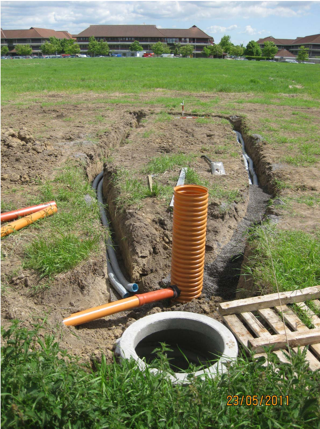
BILLEDE 6 UDLÆGNING AF DRÆN.
